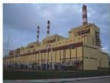
北仑湾火力发电站
